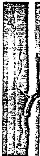
Figure 4. Severe Longitudinal Cracking
