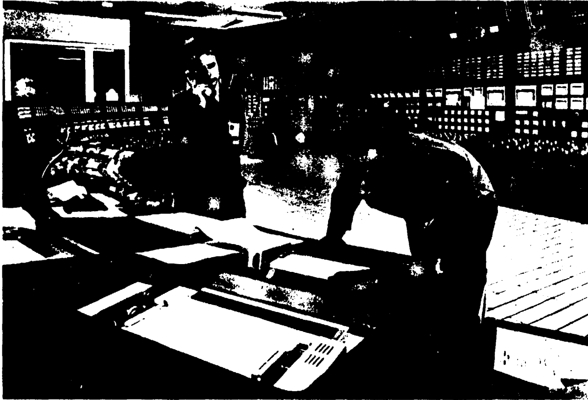
Salle de commande de la centrale du Bugey.
