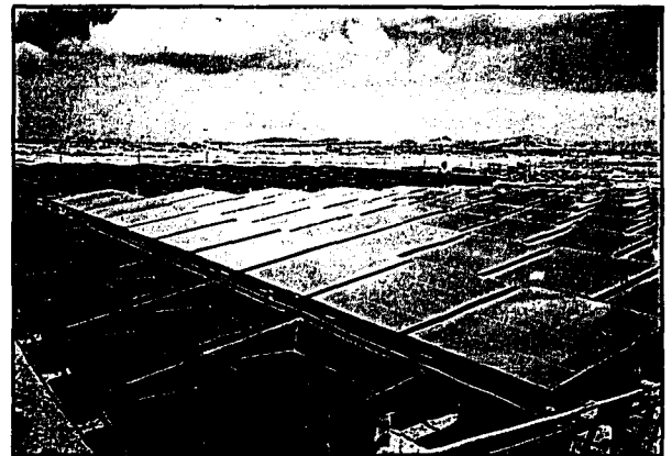
8- Planta de desalinización de agua de mar por Energía Solar. Cabo de la Vela, Guajira.
