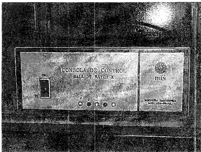
Figura 5.- Transmisor de señales digitales de la Consola de Control
