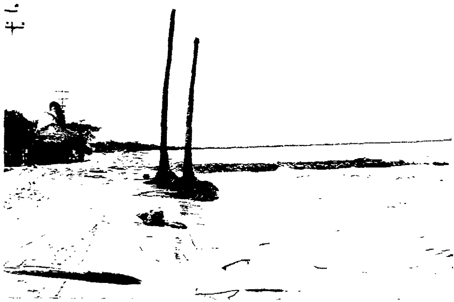
Foto 9 : Carretera Tolú - Coveñas. Vista de la carretera paralela a la playa que une a Tolú con Coveñas, y cuyo trazo, permanentemente ha ido hacia atrás en razón a los embates del mar. Obsérvese remanentes de antiguas palmeras.
