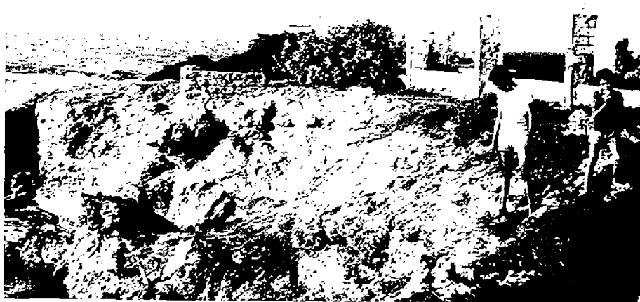
Foto 1 : Ruinas de Punta Sabanilla. Obsérvese retazos de muros y cimientos de antiguas edificaciones sobre la terraza marina de caliza arrecifal. La erosión continua con severidad sobre este sector.
