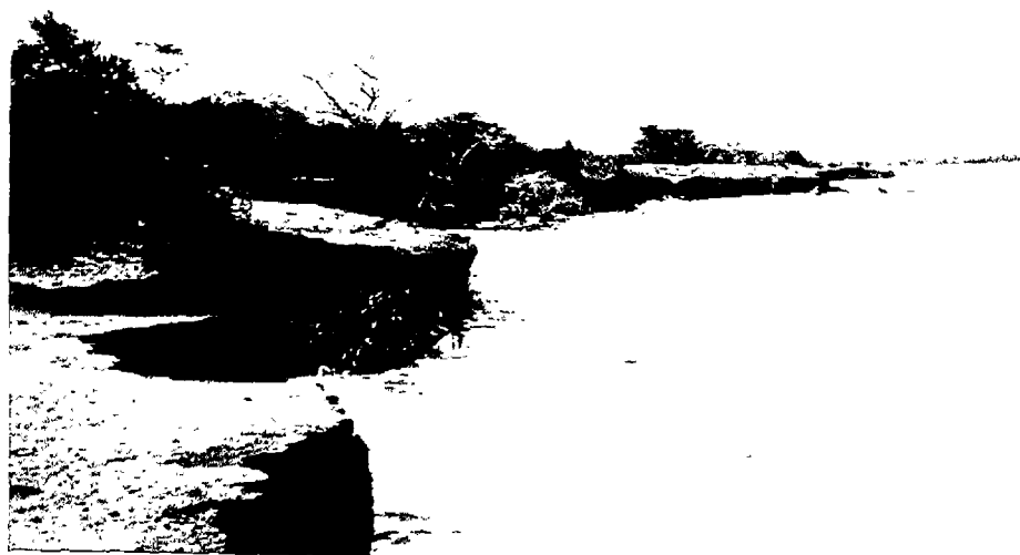
Foto 5 : Carretera a Galerazamba (Sector de Pueblo Nuevo) Banca destruida de la carretera por la acción del mar; nótese que el embate de las olas llegan con ímpetu hasta la base de la banca de la carretera.
