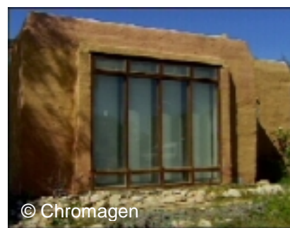
Figure 3 : Maison adobe réalisée à Sdé Boker
