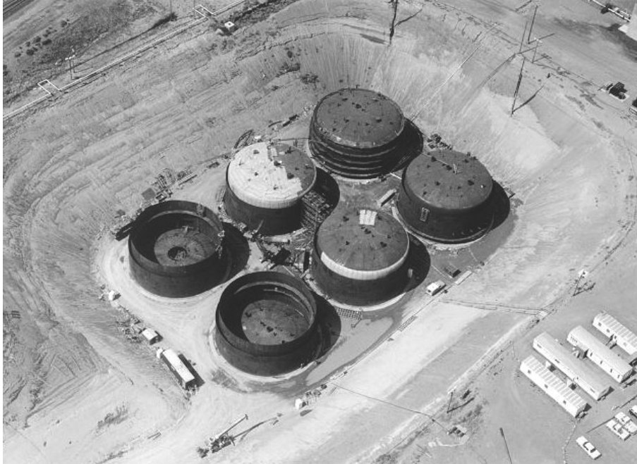
FIGURA 1. Grupo de Tanques de Pared Doble en construcción, circa 1980
