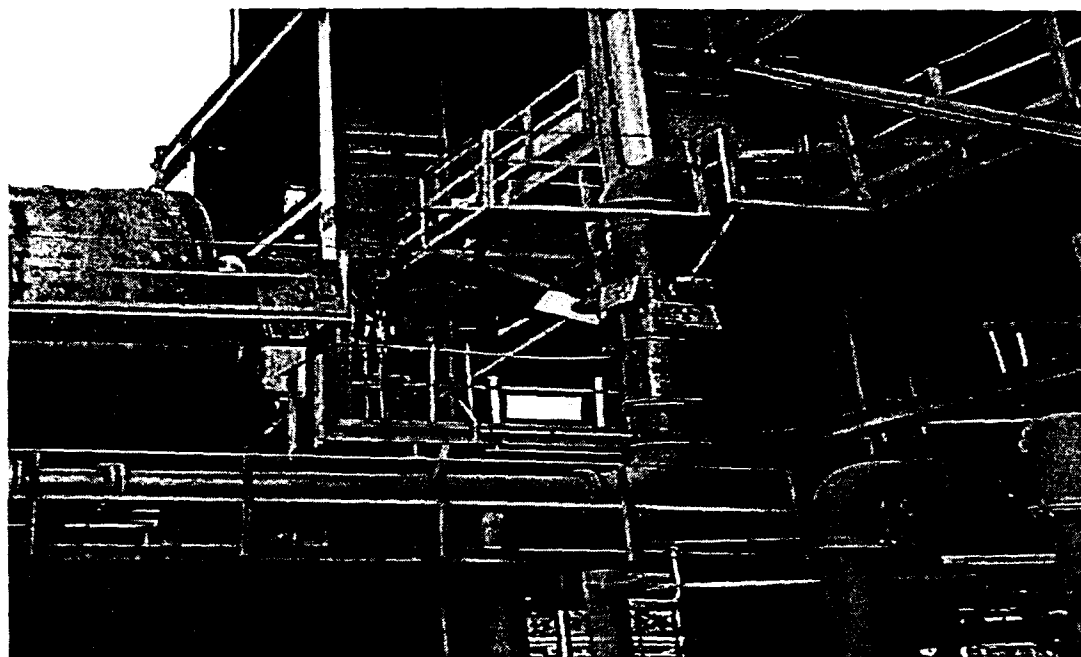
Foto 2: Parada da planta de moagem de Itabirito (Mina de Timbopeba – CVRD) – o obturador da fonte radioativa do medidor de densidade permanecia aberto até que fosse fechado por profissional da radioproteção
