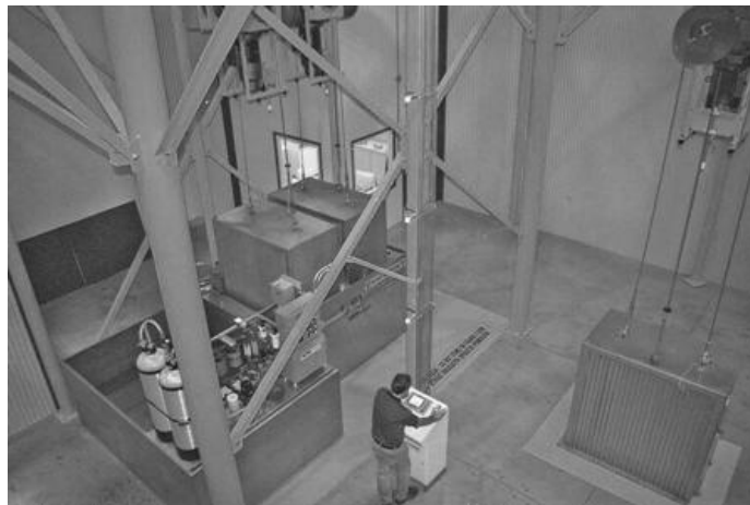
Fig. 8. Foto de instalação utilizando irradiador de categoria III
