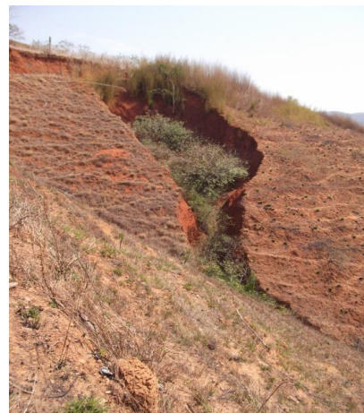
Figura 2: Erosão acelerada (voçoroca) devido à mudança da rede de drenagem para a implantação da rede dutoviária Miguel Pereira, Rio de Janeiro-Brasil.
