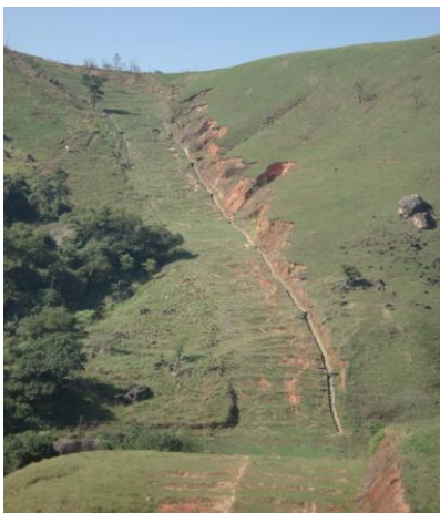
Figura 1: Linha de dutos que alterou a rede de drenagem na encosta, ocasionando o surgimento de ravinas e voçorocas Japeri-Rio de Janeiro-Brasil.
