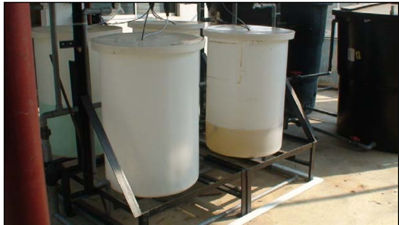
Foto 5: Larutan biobaja dimasukkan kedalam tangki nutrien sistem fertigasi
