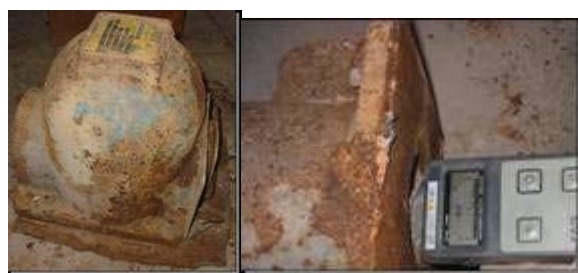
Equipo dañado por alto grado de corrosión con radionucleido Cs-137
